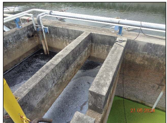
รูปที่ 3.9 Wastewater Holding Pit (F-1801)
