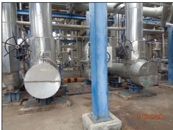
รูปที่ 3.14 Acoustic Insulation (G-624 A/B)
