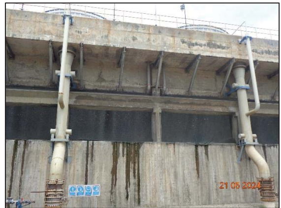
รูปที่ 3.11 Cooling Water Blowdown
