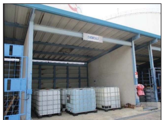
รูปที่ 3.13 พื้นที่กักเก็บป้องกันการรั่วซึมของ สารอินทรีย์ระเหย
