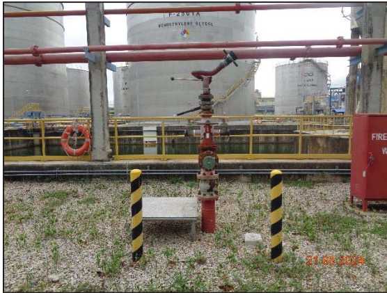
รูปที่ 3.44 Fire Water Hydrant
